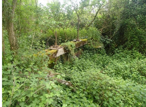
Vanne à restaurer
