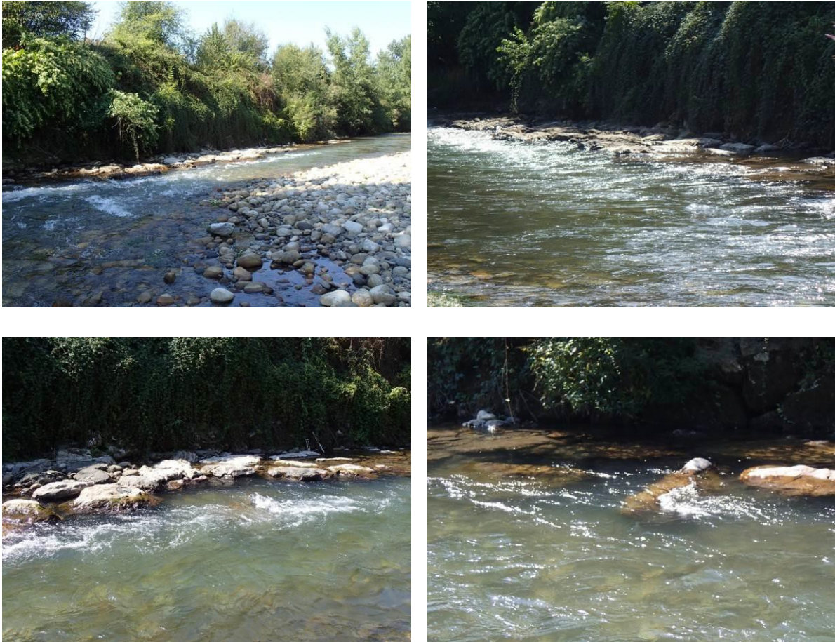
Semelle d'enrochement en cours de déstabilisation
