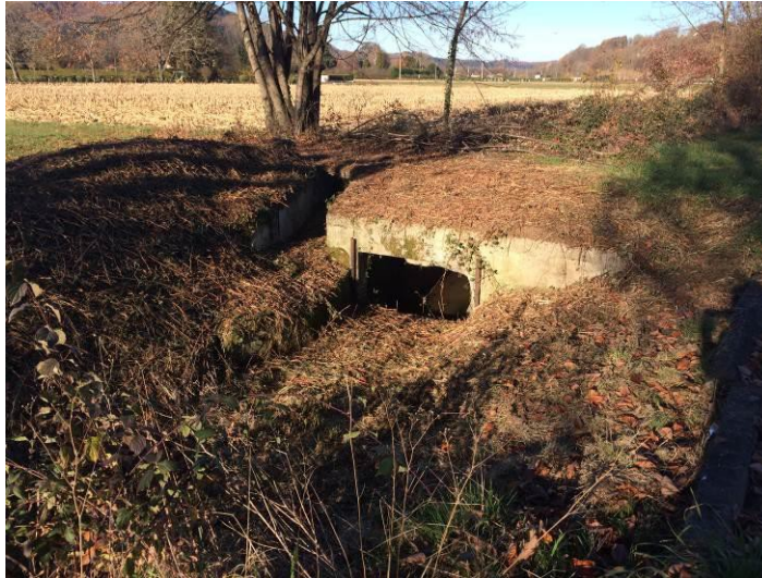
Vue amont du passage busé
