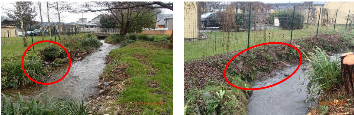
Exemples d'érosion avec risque de création de brèches
